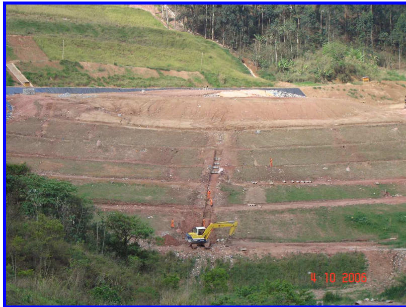
Figura 10 –Plantio de Gramíneas e Drenagem Pluvial nos Taludes Definitivos do Aterro Sanitário Fonte: Arquivo Construtora Queiroz Galvão S.A. (2006)
