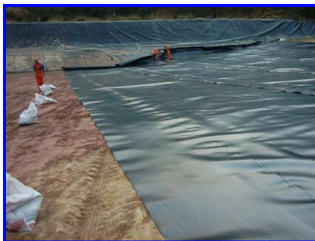
Figura 11 – Impermeabilização do Aterro Sanitário com Manta de PEAD – 2mm de espessura Fonte: Arquivo Construtora Queiroz Galvão S.A. (2005)
