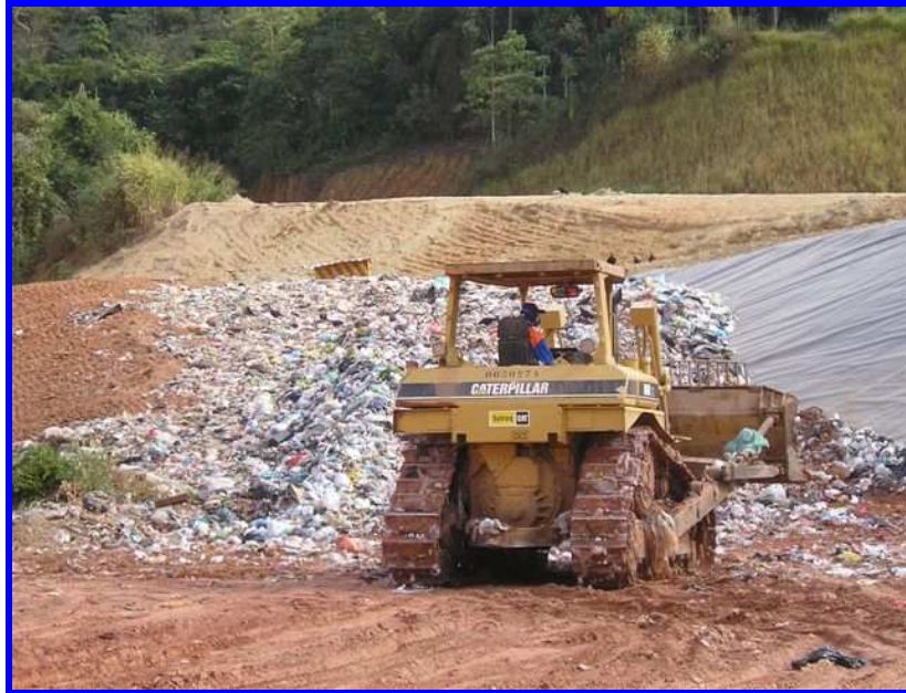
Figura 9 – Compactação dos Resíduos no Aterro Sanitário com Rampa de 1:2,5 Fonte: Arquivo Construtora Queiroz Galvão S.A. (2006)
