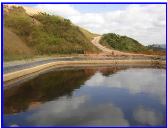
Figura 12 – Tanque de Percolados Fonte: Arquivo DEMLURB (2005)
