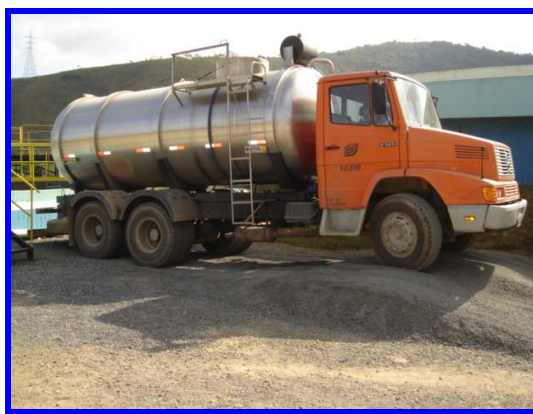
Figura 13 – Descarga de Percolados na ETE Fonte: Arquivo DEMLURB (2006)
