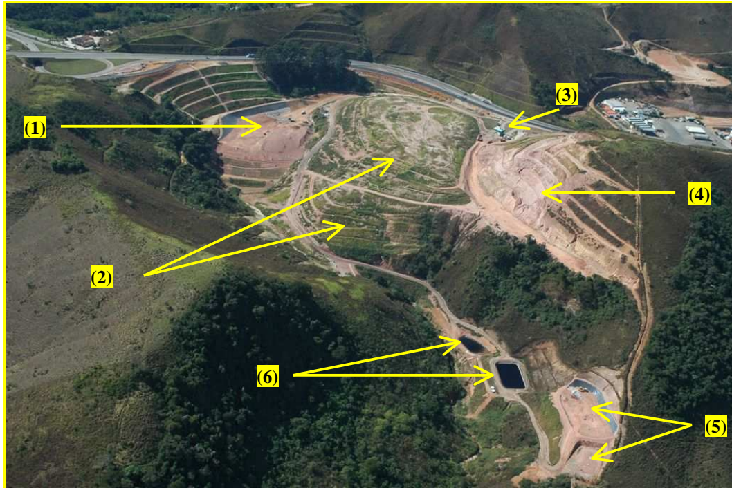
Figura 3 – Foto aérea do Aterro Sanitário de Salvaterra (data: 22/06/2006) Fonte: Arquivo DEMLURB (2006)
