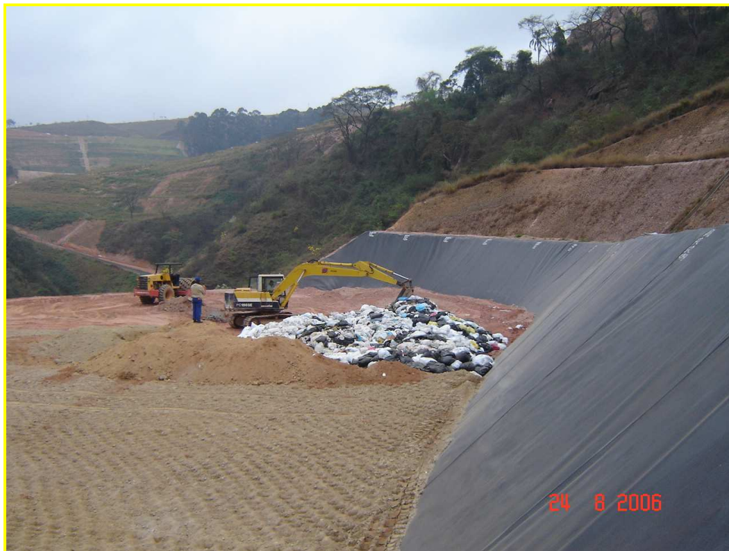
Figura 4 – Foto da Operação da Vala Séptica de RSS (data: 24/08/2006) Fonte: Arquivo DEMLURB (2006)
